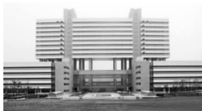
山东德州市政府大楼 资料图片
