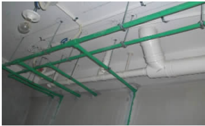
水管必须从顶面走,使用吊筋固定
