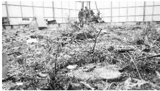
施工围挡内的4棵水杉树已被砍伐 现代快报记者 辛一 摄
