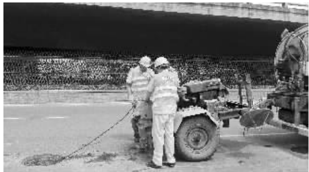
工作人员对管道进行清疏
