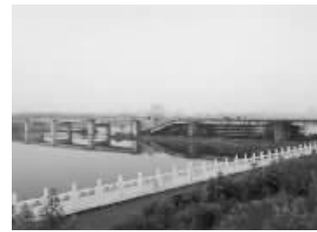
大桥坍塌现场
