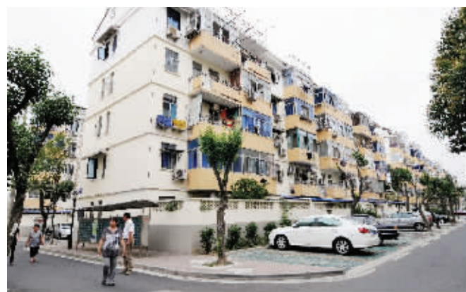
不要5个月,勤业一村等老小区就会像浦北新村一样大变样 张敏 摄
