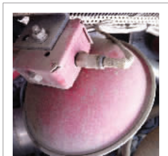
灭火弹有点像红色大碗,一旦哪里异常高温,就会爆炸,喷出干粉覆盖,为救援赢得时间。
