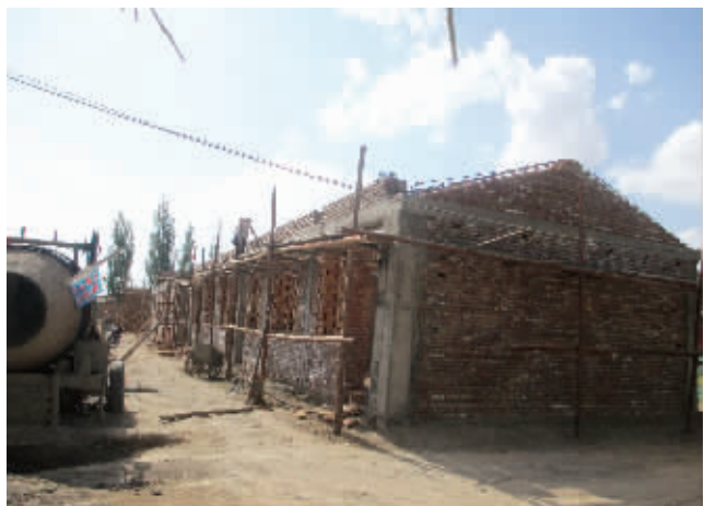
工人加班加点,两栋新校舍目前已经封顶 海原学子拍摄
