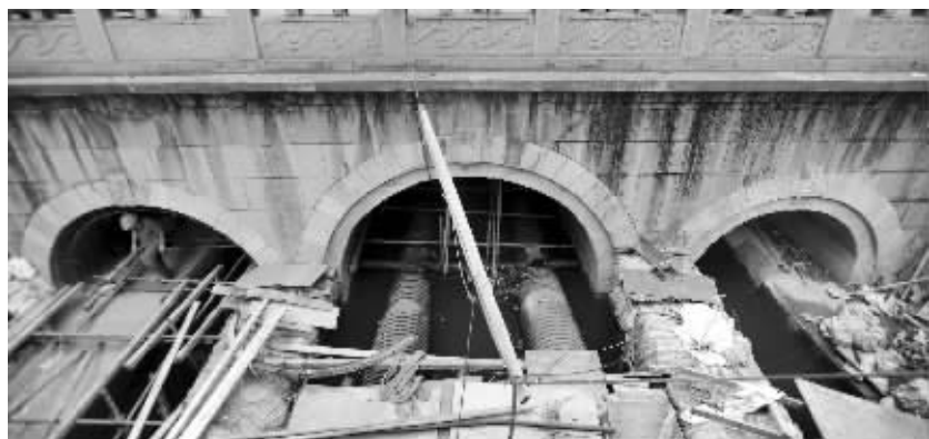
浮桥桥洞涂上了一层水泥,有的桥洞还搭起了钢筋架子 现代快报记者 施向辉 摄
