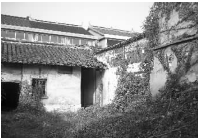
拆除前的吴介璋故居 报料人供图
