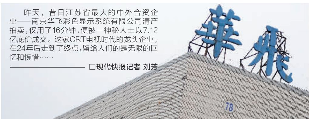
华飞公司厂房上的霓虹灯已经破损,透出无限的苍凉 现代快报记者 施向辉 摄
