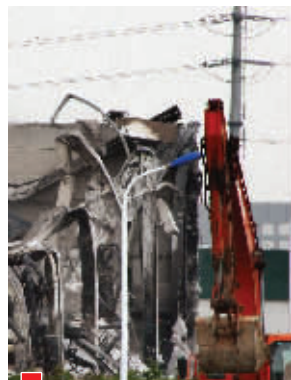
挖掘机在扒仓库外墙
