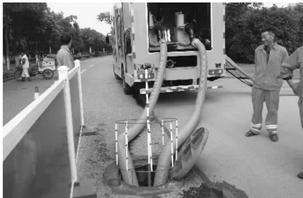
防护罩能卡住窨井口,防止行人掉下去 胡姗姣 摄
