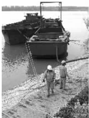
工地泥浆水排到船上
