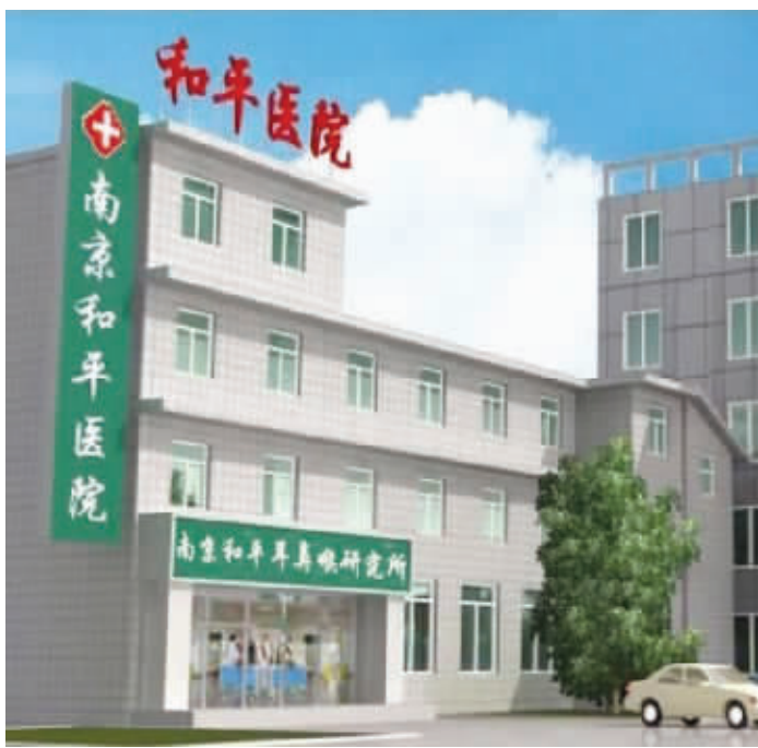
南京和平医院大楼
