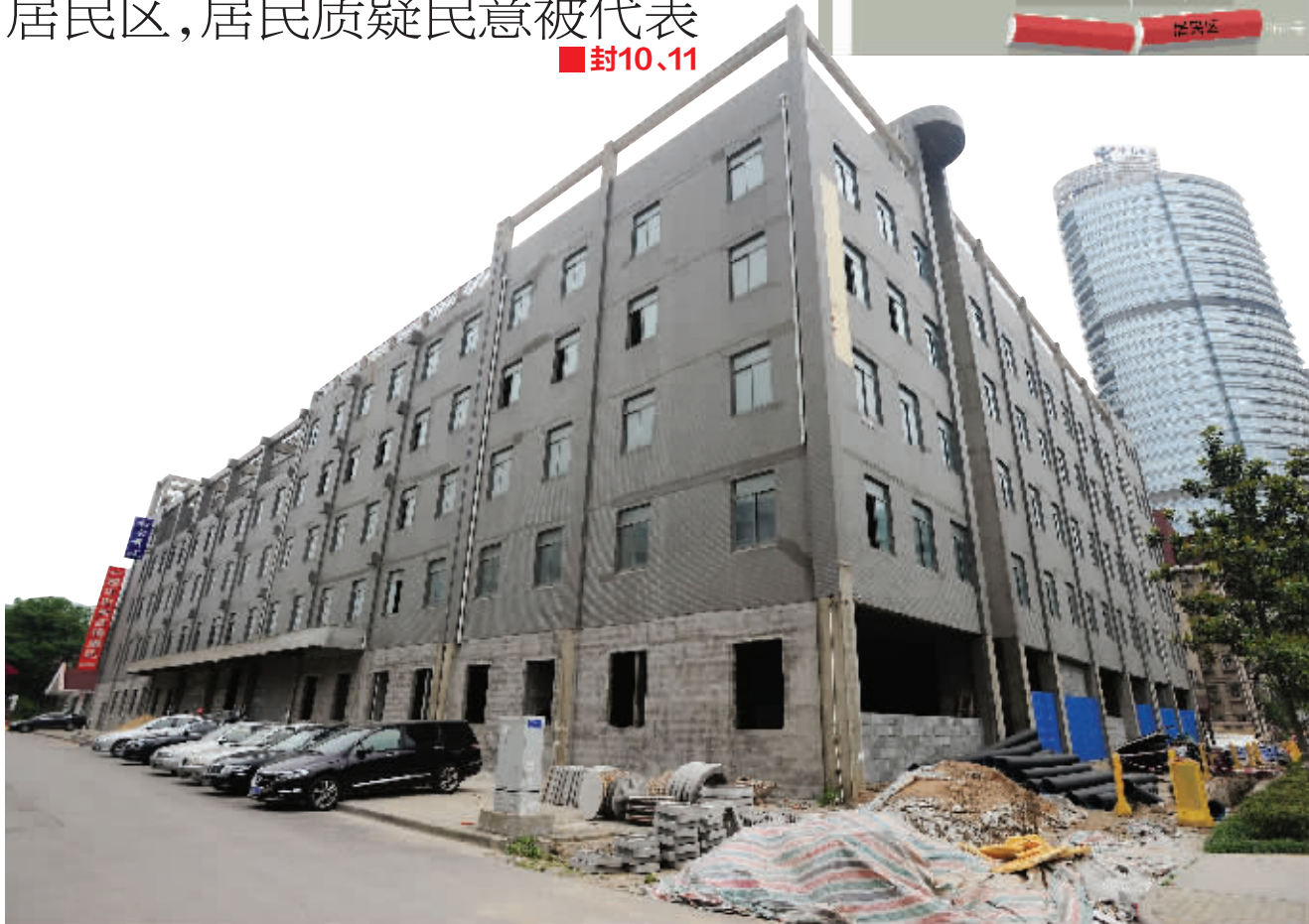
这个遭到附近居民集体反对的医院正在装修中 现代快报记者 施向辉 摄
