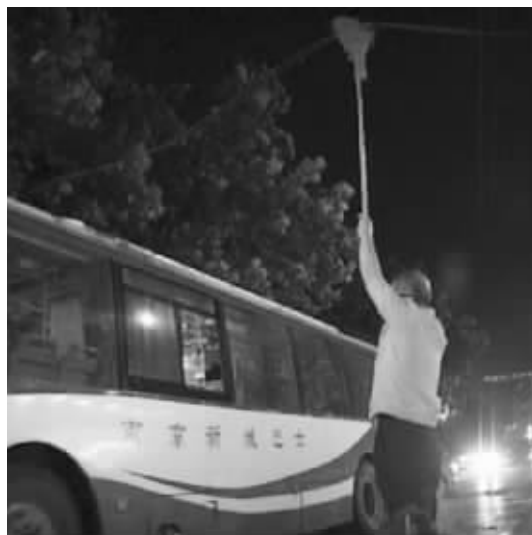
老交警徐震用扫帚顶起电缆 报料人供图
