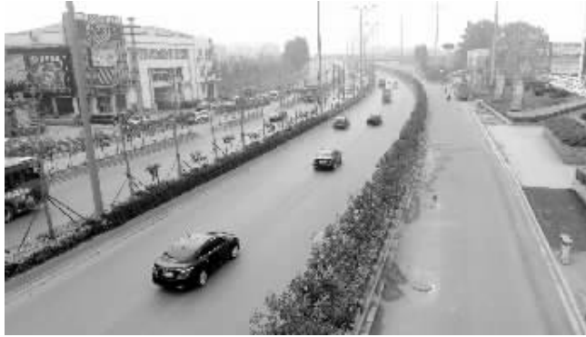
正在建设中的纬一路 现代快报记者 赵杰 摄
