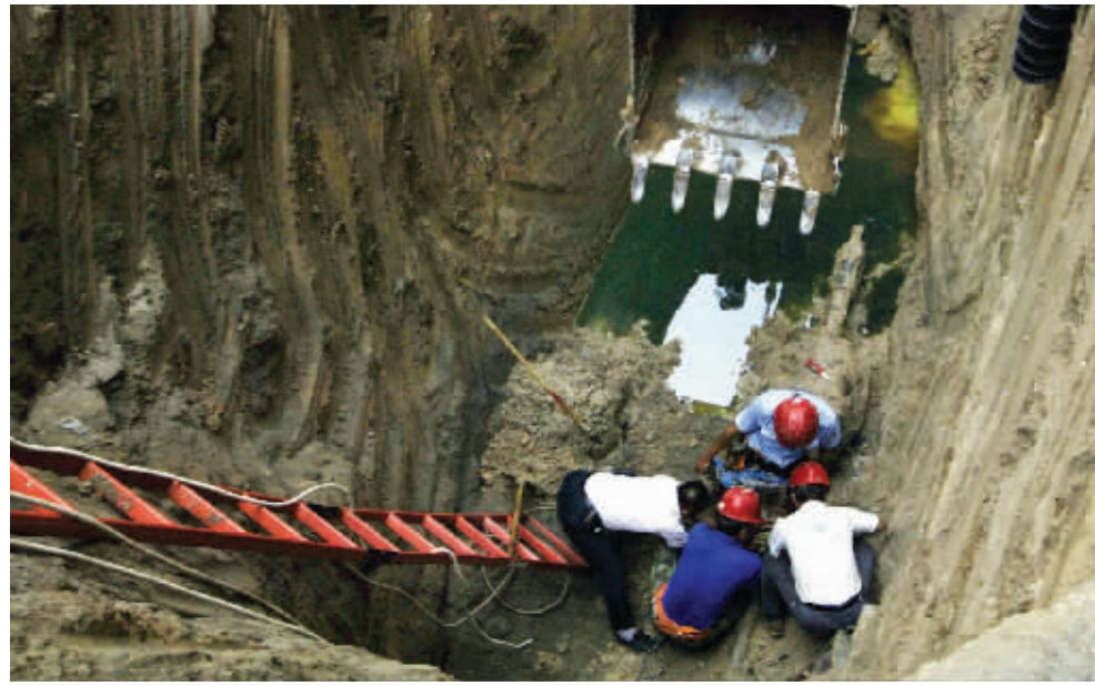
5月25日,工作人员在抢修被挖断的输油管道 新华社记者 郭绪雷 摄
