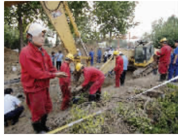
工作人员现场抢修 新华社记者 郭绪雷 摄
