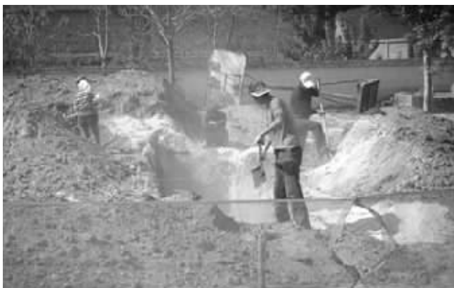
工人正在施工 马建梅 摄
