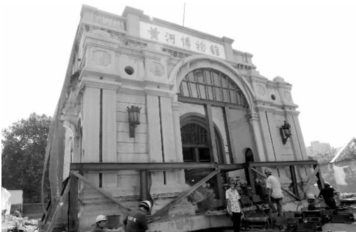
5月19日,工程人员在黄河博物馆内部观察平移施工
