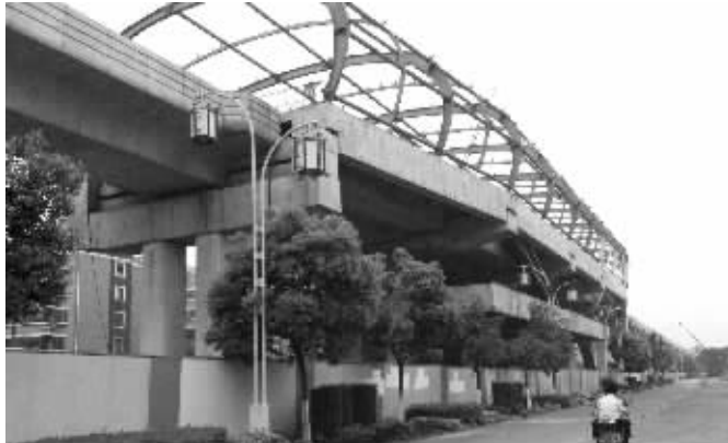
2号线高架站已显现雏形
