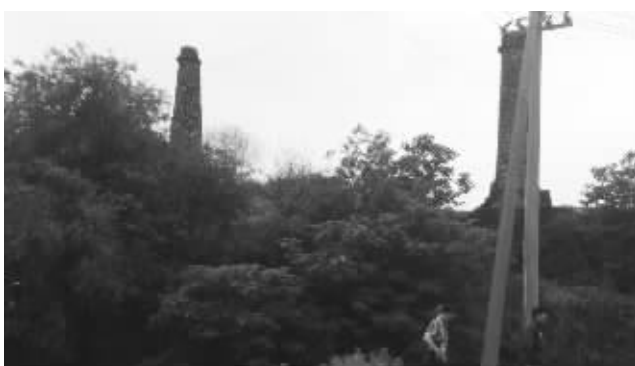
窑体被郁郁葱葱的树木覆盖,周边还有电线杆大煞风景
