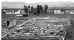
本·拉丹生前在阿伯塔巴德的住所已被拆除
