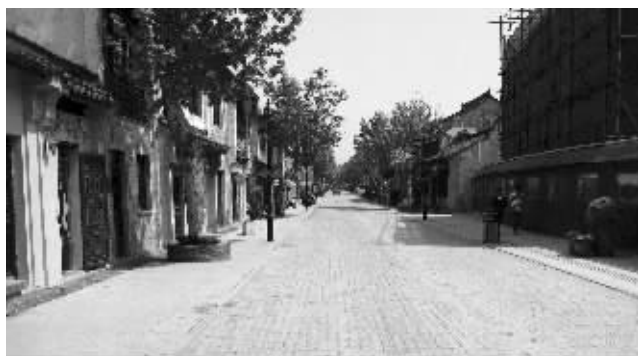
尘土遍地, 沿街很多工程还未结束
