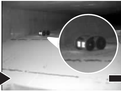
施工前检测机器人在管道内检测
