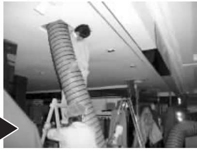
施工人员接捕尘器进行集尘
