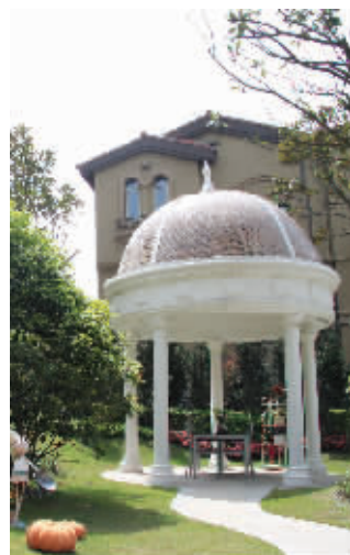
“花园标杆”的建筑风格处处体现出尊贵、典雅
