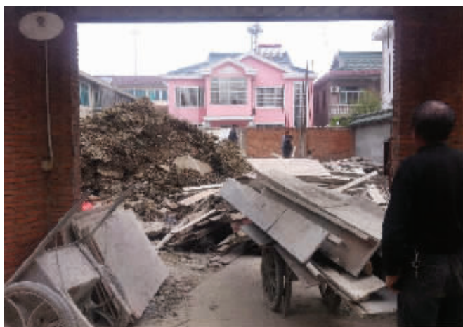
工人们正在施工 唐奕摄
