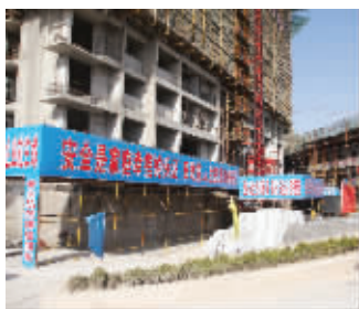
整个保障房项目正照常全速推进
