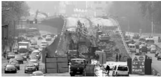
昨天,草场门引桥开始施工 现代快报记者 赵杰 摄
