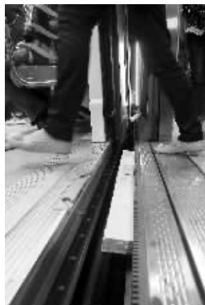
地铁汉口中门站安装泡沫试验条 现代快报记者 顾炜 摄
