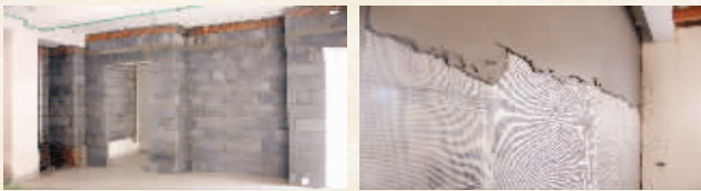
▲红砖斜砌防止墙顶面接缝处开裂 ▲轻质墙必须先上抗裂布,再粉刷
