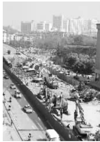
汉中门高架桥南端爆破前匝道机械拆除施工中
