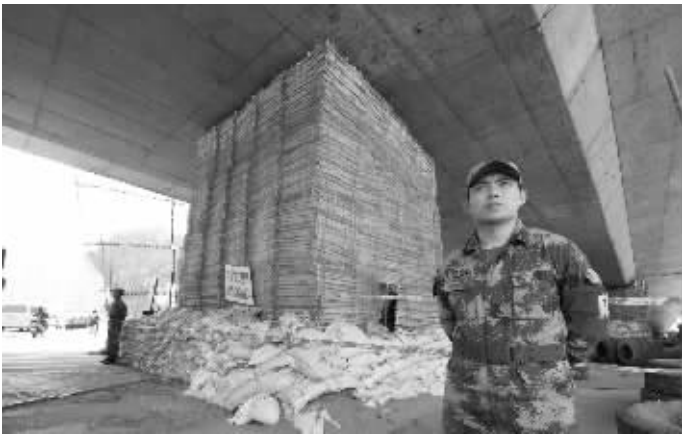
爆破前,清凉门高架桥下安保人员守护安装好炸药的桥墩
