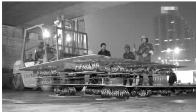
爆破前,汉中门高架桥下,防震设备到位
