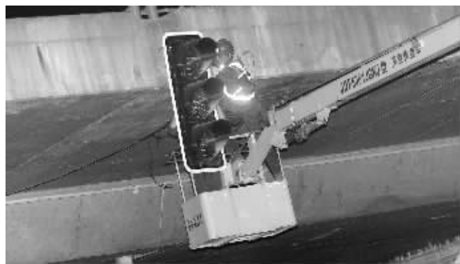
爆破前,工作人员正在拆除信号灯
