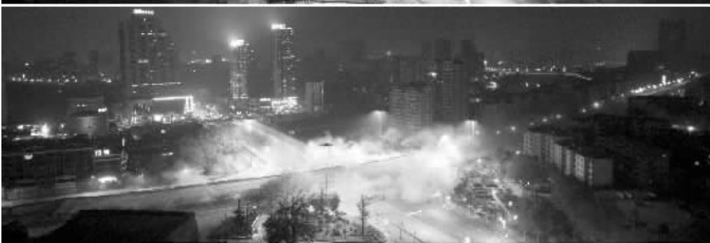
昨晚22:00,汉中门高架爆破的第一道“闪电”划破夜色。之后,“闪电”伴随着一声声巨响,汉中门高架桥在6.9秒后塌下 本版摄影 现代快报摄影部
