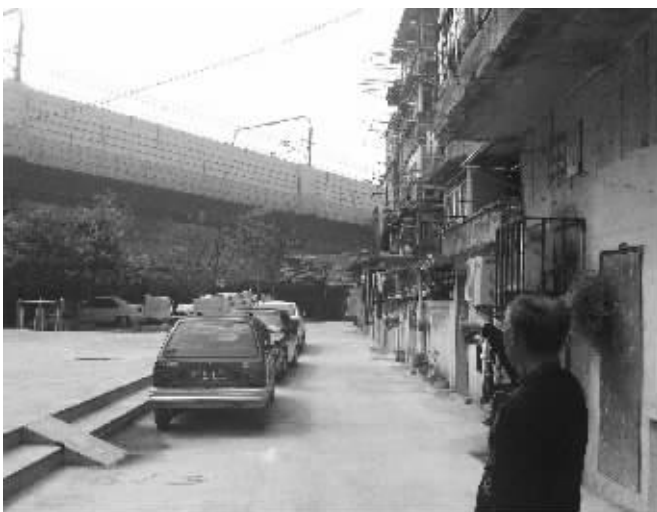
地铁与居民楼最近处只有8米
