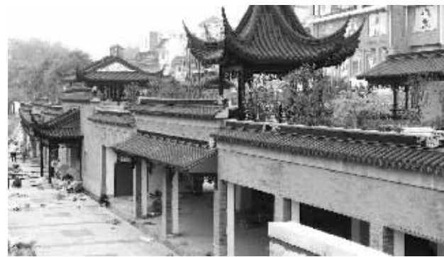
正在建设的小吃城,未来将集中展现秦淮风味
