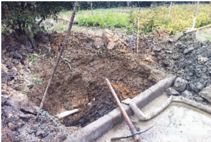
3号楼门前已经挖开 匡笠 摄
