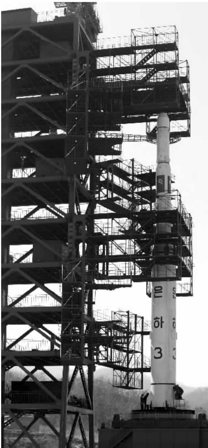
4月8日在朝鲜平安北道铁山郡东昌里的“西海卫星发射场”拍摄的已经基本安装完成的“银河3号”运载火箭 新华社记者 张利 摄
