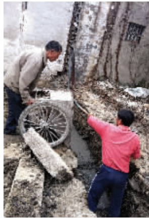
施工人员用混凝土浇地基
