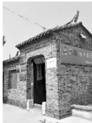
卢秉枢纪念馆外观
