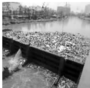
金川河泵站外漂浮着很多垃圾 快报记者 顾炜 摄
