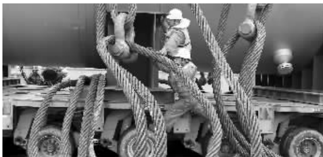
吊装上车后，解开大腿粗的钢缆
