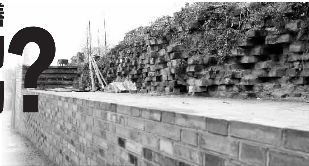
神策门段城墙修缮现场 快报记者 顾炜 摄
