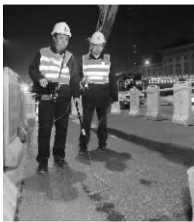
工作人员在寻找“漏气点”
