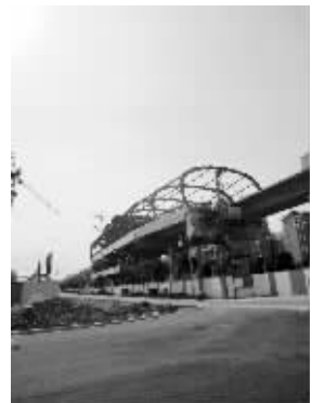
阳澄湖中站台的主体结构已基本搭建完成
