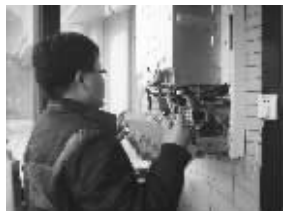
杨工程师正在对贝雷塔锅炉进行诊断
