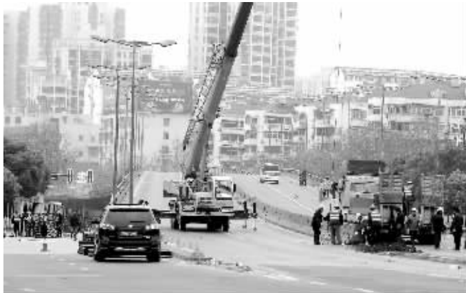
水西门高架桥面封闭,令车辆通行遭遇瓶颈 快报记者 顾炜 摄
