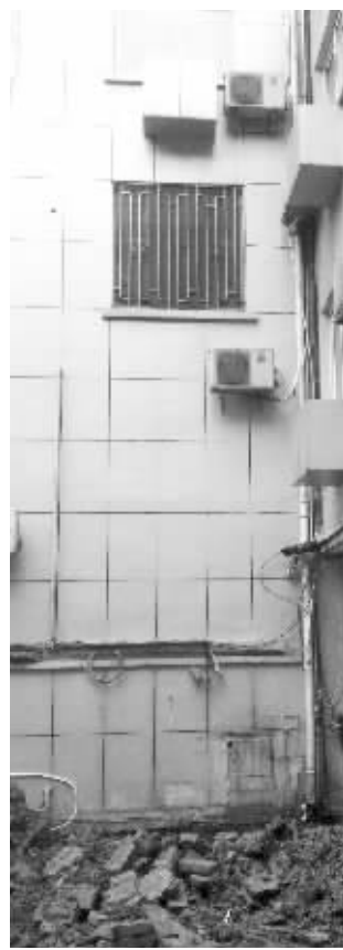
现场已经开挖电梯下沉坑
