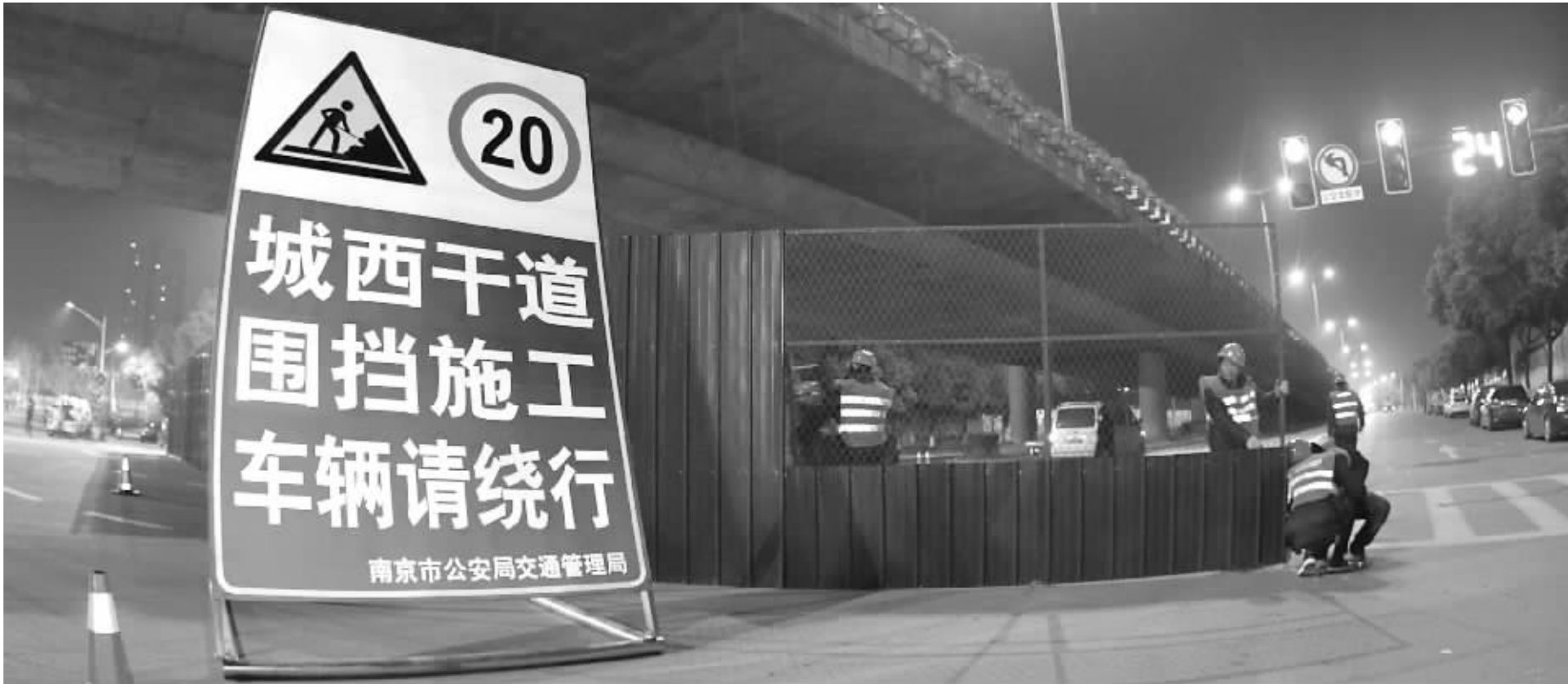
昨晚10点,水西门高架附近的地面道路开始围挡。范围从第二机床厂至通宇大厦,沿着水西门高架地面路段进行围挡防护,大约有两公里 快报记者 顾炜 摄
