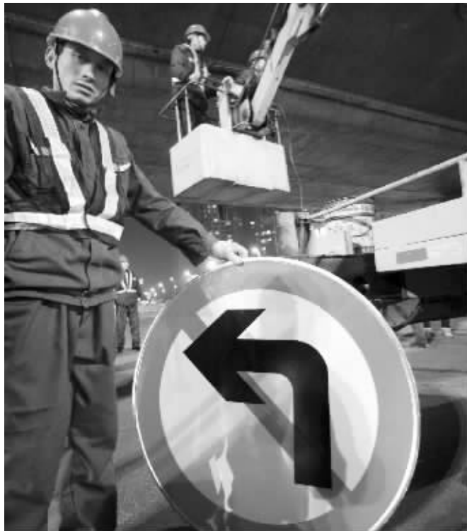
施工人员更换水西门高架上的指示牌 快报记者 路军 摄
