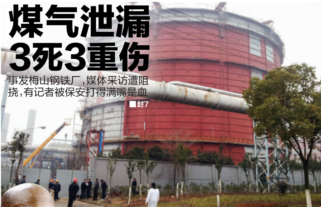
这是发生事故的煤气柜。经初步调查，事故原因是施工人员在检修过程中割断了煤气封堵盲板螺栓，煤气倒灌进柜内 快报记者 辛一 摄
