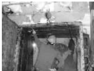
施工人员正在进行土层冷冻
